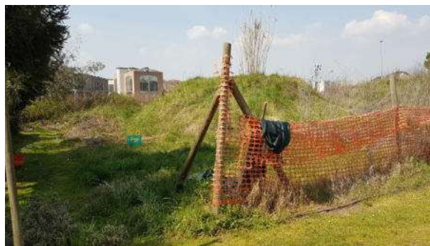
Area oggetto di intervento – vertice Sud-Est
