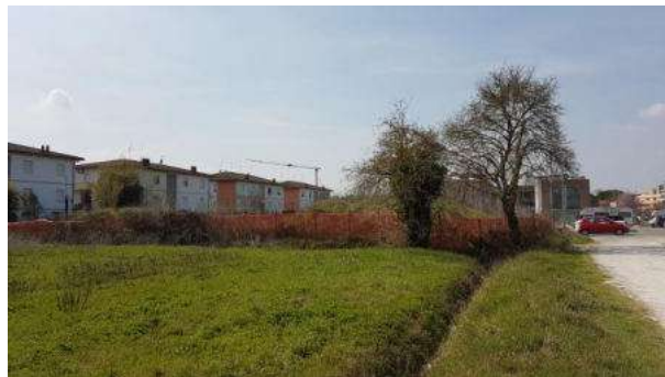
Area oggetto di intervento – vertice Nord-Est
