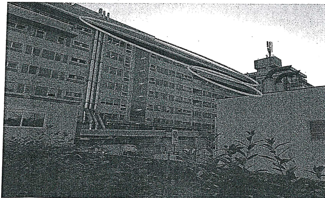
VISTA DELLE ZONE DI INTERVENTO
