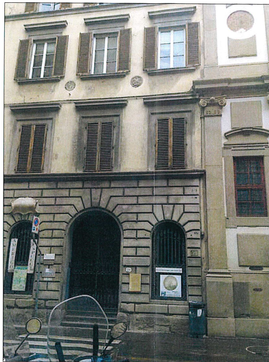
FACCIATA PARTE VIA BORGOGNISSANTI
