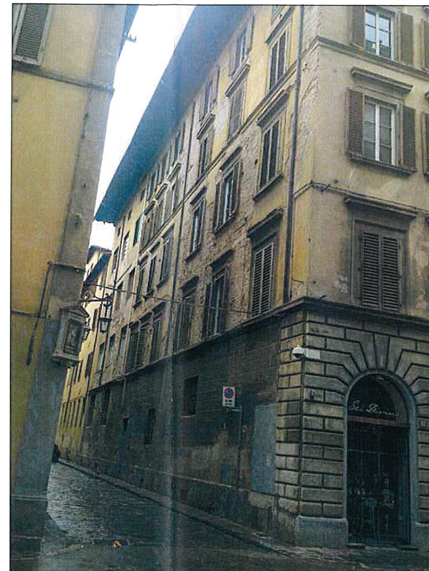
FACCIATA PARTE VIA DEL PORCELLANA
