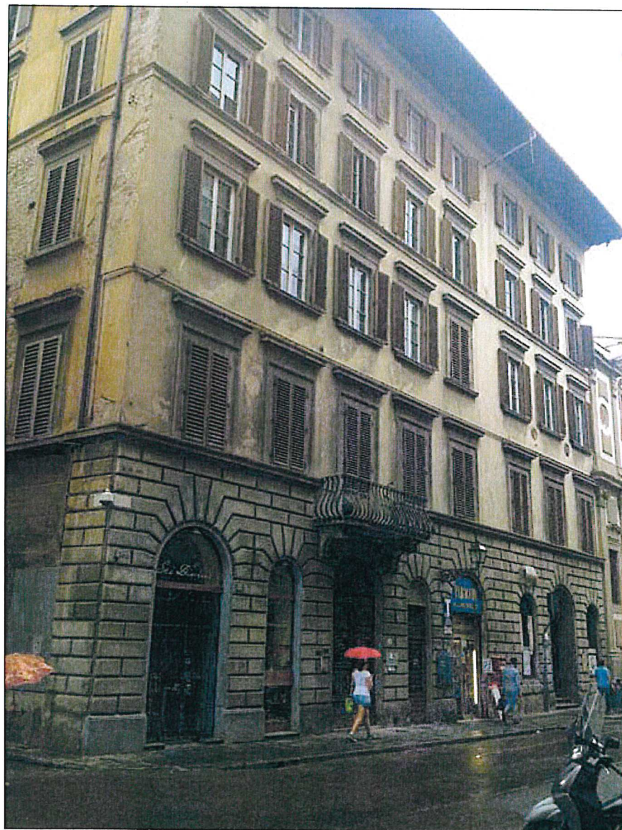
FACCIATA PARTE VIA BORGOGNISSANTI
