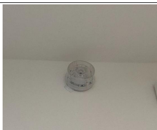
Pannello allarme ottico-acustico
